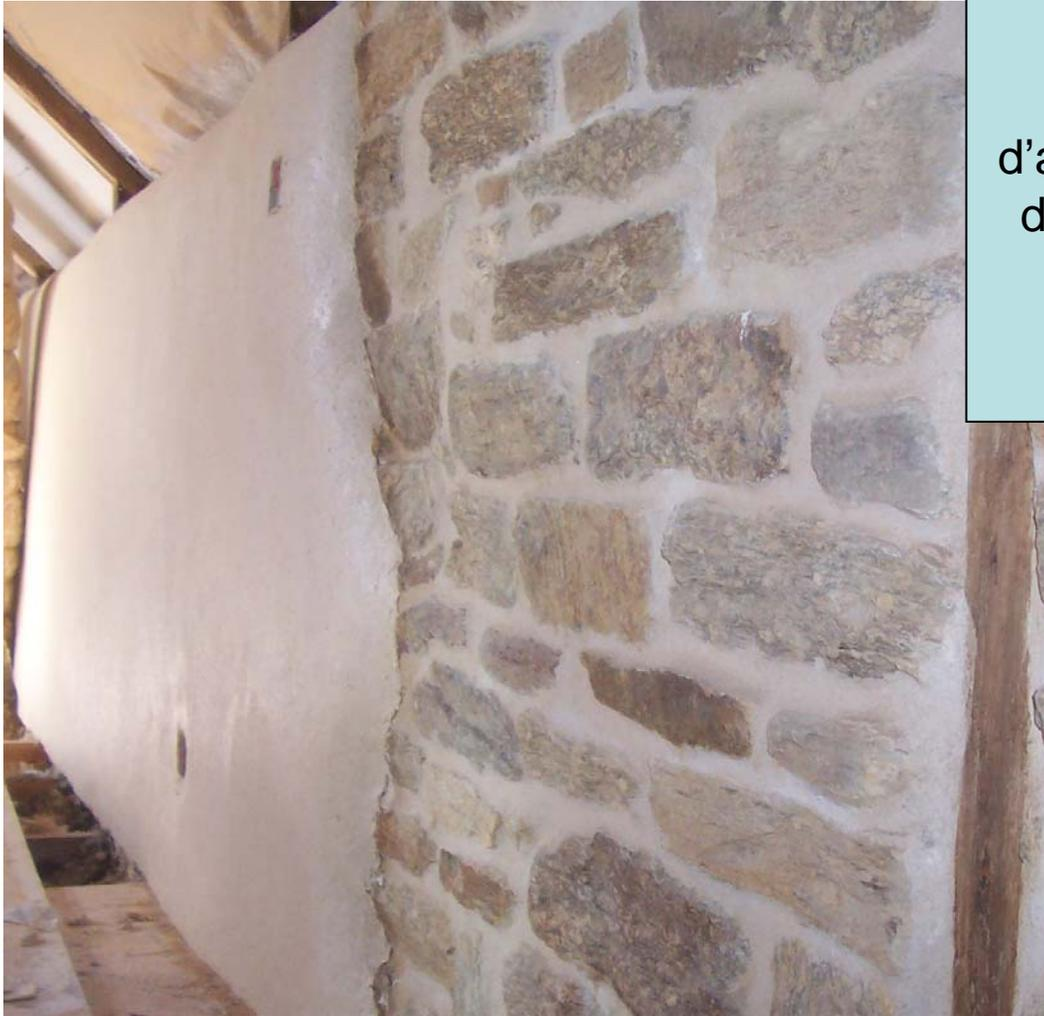
Le chanvre et chaux étant souple et malléable comme matériau, il est possible d'arrondir les angles aux fenêtres, d'insérer des pierres, du bois ...
