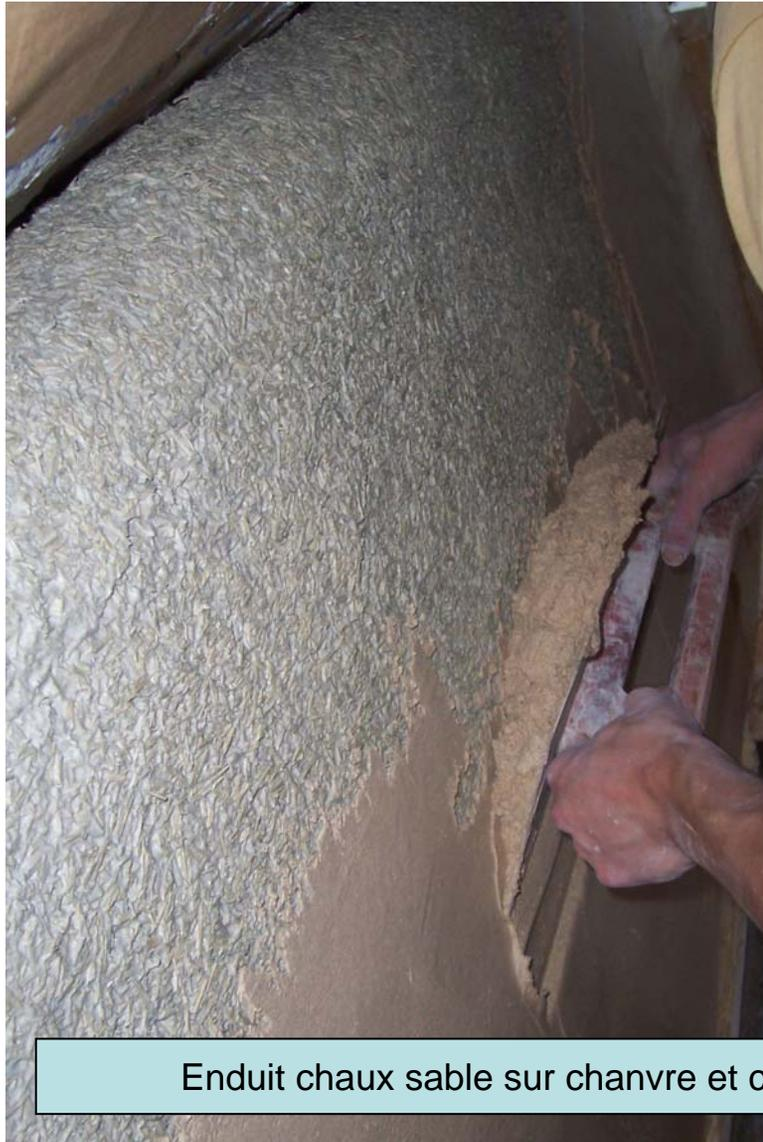
Enduit chaux sable sur chanvre et chaux de 5 cm
