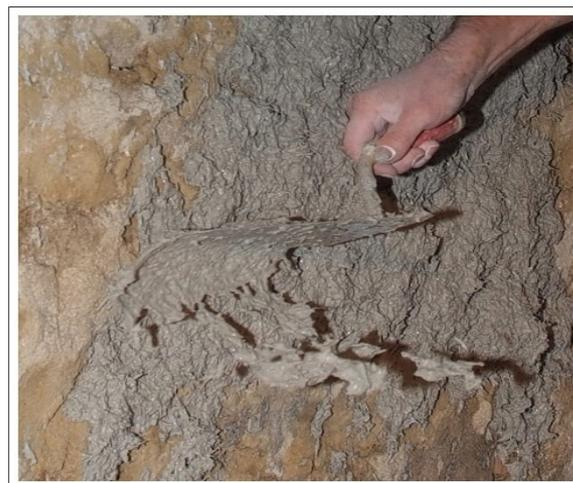
Après projection d'une certaine quantité de mortier, il faut rapidement l'étaler sur le mur, dans un mouvement vertical, avec la taloche. Celle-ci doit être tenue fermement en écartant légèrement la partie supérieure, pour ne pas entraîner tout le mortier, mais bien pour l'étaler.
