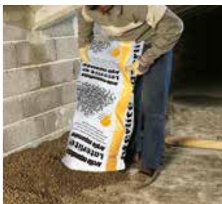
L'argile expansée Laterlite est un granulat léger dérivé de l'expansion à hautes températures (1200°C) d'argiles naturelles spéciales.
