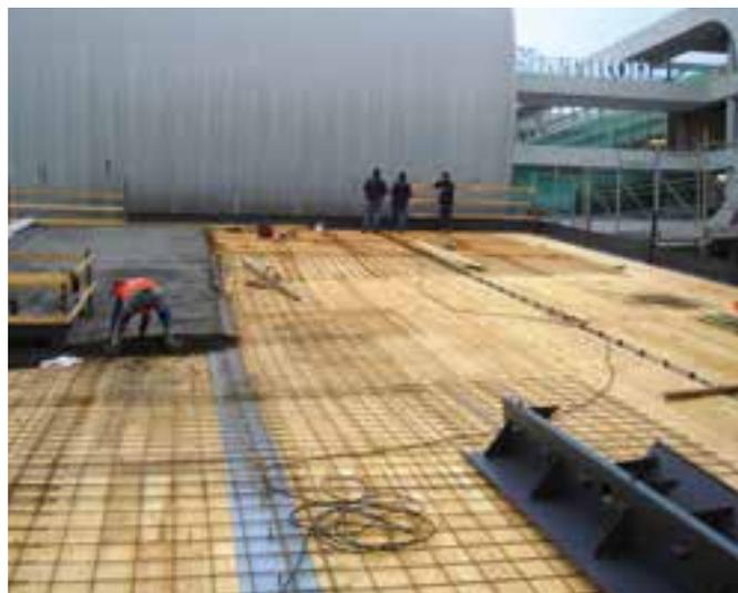
La solution envisage la réalisation d'un plancher structural – dalle béton ou plancher hourdis – en béton structural léger. En fonction des conditions et des contraintes existantes ou demandées (épaisseur, charges, etc.), la solution peut être complétée avec plusieurs types de chape légère ou technique / ravaillage léger (voir fiche L1m L1c).
