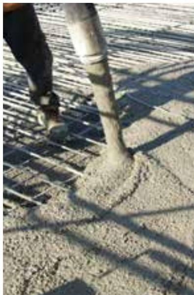
Transport à l'étage du béton structural léger en sac (Latermix Béton) gâché avec malaxeur-transporteur pneumatique.
