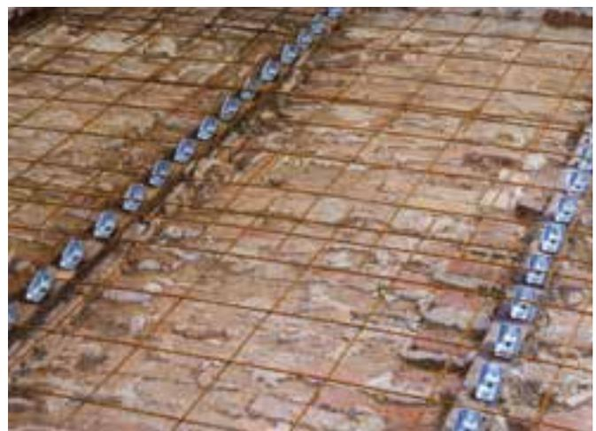
La solution envisage la pose, au-dessus de la structure existante en béton (dalle béton, plancher hourdi béton, etc.) d'une dalle en béton structural léger armé et collaborant, assemblée à la structure existante par des connecteurs mécaniques et/ou chimiques. En fonction des conditions et des contraintes existantes ou demandées (épaisseur, charges, etc.), la solution peut être complétée avec plusieurs types de chape légère ou technique / ravaillage léger (voir fiche L1m L1c).
