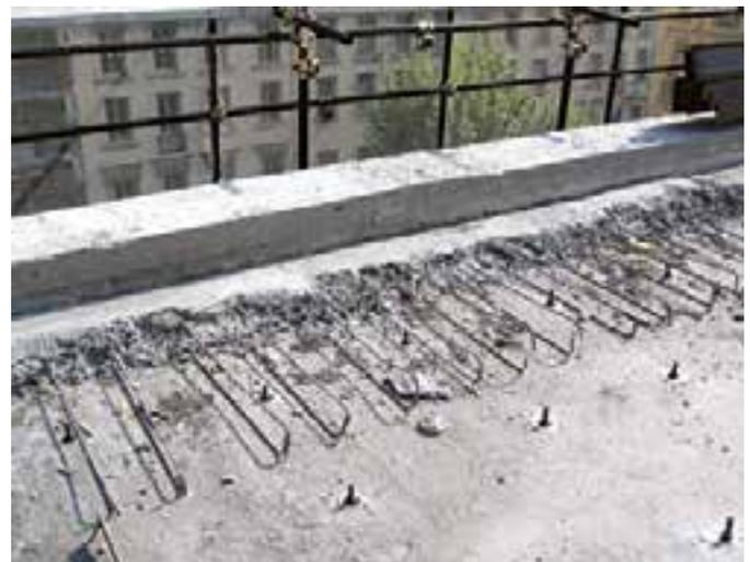
La solution envisage la réalisation d'un plancher structural réalisé par une tôle nervurée aux caractéristiques variables en fonction des charges d'exploitation et de la portée, et par une dalle collaborante en béton structural léger armé. Le plancher est réalisé sur un support porteur (poutres acier, béton, bois ainsi que des solives ou des maçonneries) avec lequel il peut être assemblé à la dalle par des connecteurs mécaniques.
