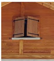
Dans la mesure où l'on choisit d'exprimer une ossature bois apparente, on dispose les fenêtres en cohérence avec le système constructif.
