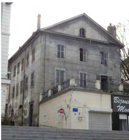
*Évian, décor de grisaille au badigeon de chaux sur enduit : faux appareil et frise à décor floral en grisaille sous le fronton (immeuble prévu détruit pour la réalisation de logements neufs).*
