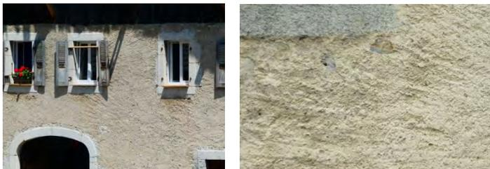
**Rendre une maçonnerie apparente, avec un effet d'écorché, est donc à la fois une aberration technique et une perte des caractéristiques patrimoniales.** Ci-dessous les pierres ont été dénudées de leur enduit et un rejointoiement a été refait au ciment artificiel. Ceci contredit la façon dont les maisons ont été conçues et contribue par ailleurs à dégrader le mortier de chaux de liaison de la maçonnerie et à accentuer les remontées capillaires.
