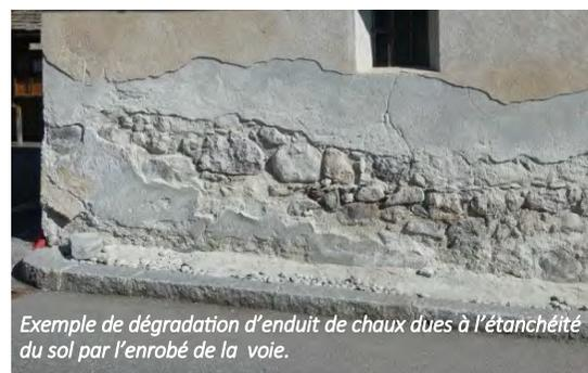
Exemple de dégradation d'enduit de chaux dues à l'étanchéité du sol par l'enrobé de la voie.
