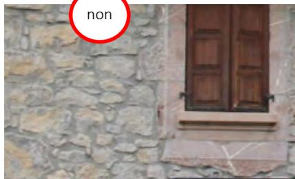
Ici on observe les mêmes pierres de calcaire rose local, en encadrement de fenêtre sur un édifice de la vallée d'Abondance. Comme décrit ci-dessus la façon dont les pierres sont taillées montre l'endroit exact où était prévu l'arrêt de l'enduit. Seule une bande autour de la fenêtre était visible et le reste du mur était enduit.
