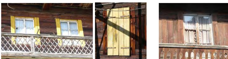
Dans les structures bois à ossature apparente, pas de cadres de fenêtres : les piédroits sont de simples montants qui interrompent les plateaux sans former de saillie (comme les poteaux de charpente).
