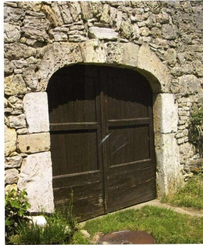
▲ ASSEMBLAGE À JOINTS VIFS À DRIGAS
